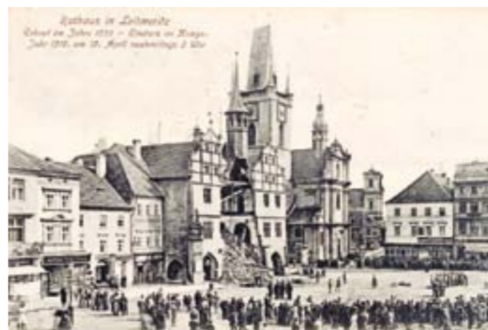
Archivní snímek ukazuje zřícení celé části průčelí budovy v dubnu roku 1916.
