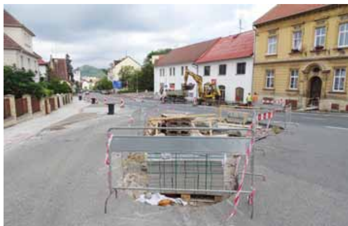
Práce na stavbě nového přechodu pro chodce Na Kocandě probíhají za provozu, řidiči musejí být opatrní. Foto: Radim Tuček
