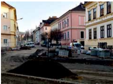
Hlavní část stavebních prací nyní probíhá na křižovatce ulic Palachova a Křižíkova.
