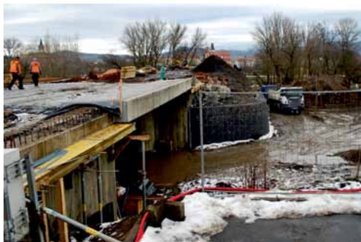
Tyršův most z železické strany na konci ledna. Zhotovitel stavby předložil aktualizovaný harmonogram prací, který posouvá zprovoznění mostu do dubna. Foto Ondřej Přecechtěl
